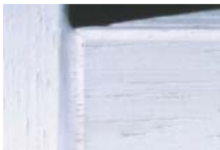
Защищенные V-швы с помощью Kodrin WV470
